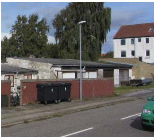
Rundt om i området findes ejendomme og garage- ▼ anlæg, der er meget nedslidte.
