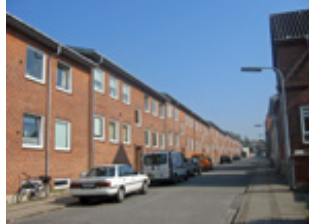
Bebyggelsesstrukturen med udsigtslinier til fjorden skal sikres.
