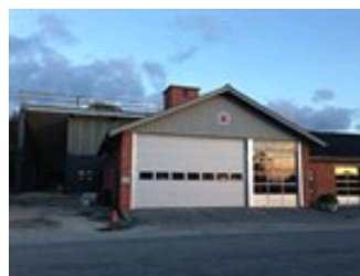
Opførelse af ny brandstation
