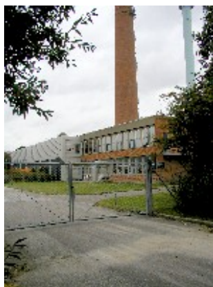
Varmecentralen på Vikingevej.
