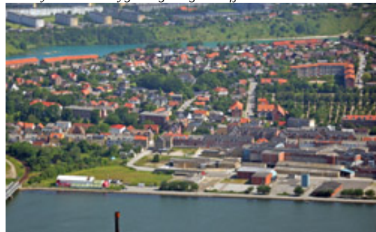
Slakterigrunden før nedrivningen af nedslidte bygninger.
