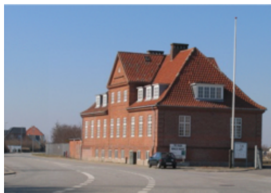
Den tidligere administrationsbygning til Norden udgør den mest synlige markering af Mølholms historiske bebyggelsesstrukturer.
