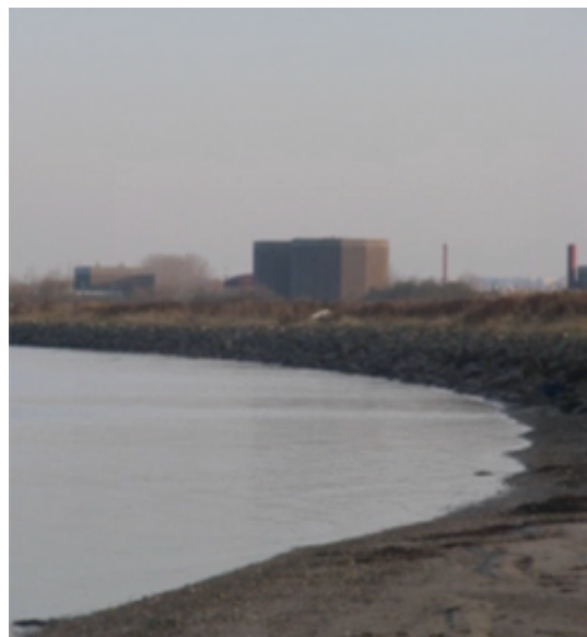
Rensningsanlægget markerer overgangen mellem by og fjordeng.
