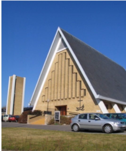
Vesterkær Kirke er et vigtigt orienteringspunkt i nærområdet.
