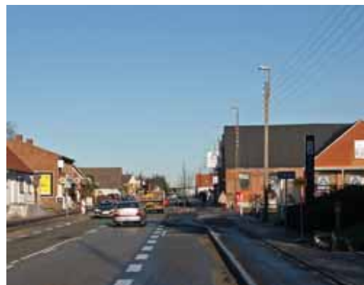
Gugvej er renoveret for at øge trafiksikkerheden.
