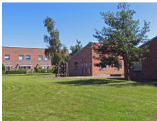
Tæt-lav ved Fredrik Bajers Vej.
