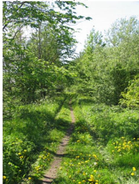
Banestien benyttes i dag som en trampesti direkte på det eksisterende bærelag fra banens anlæggelse. Der mangler en overfladebelægning og hegning mod landbrugsarealer.
