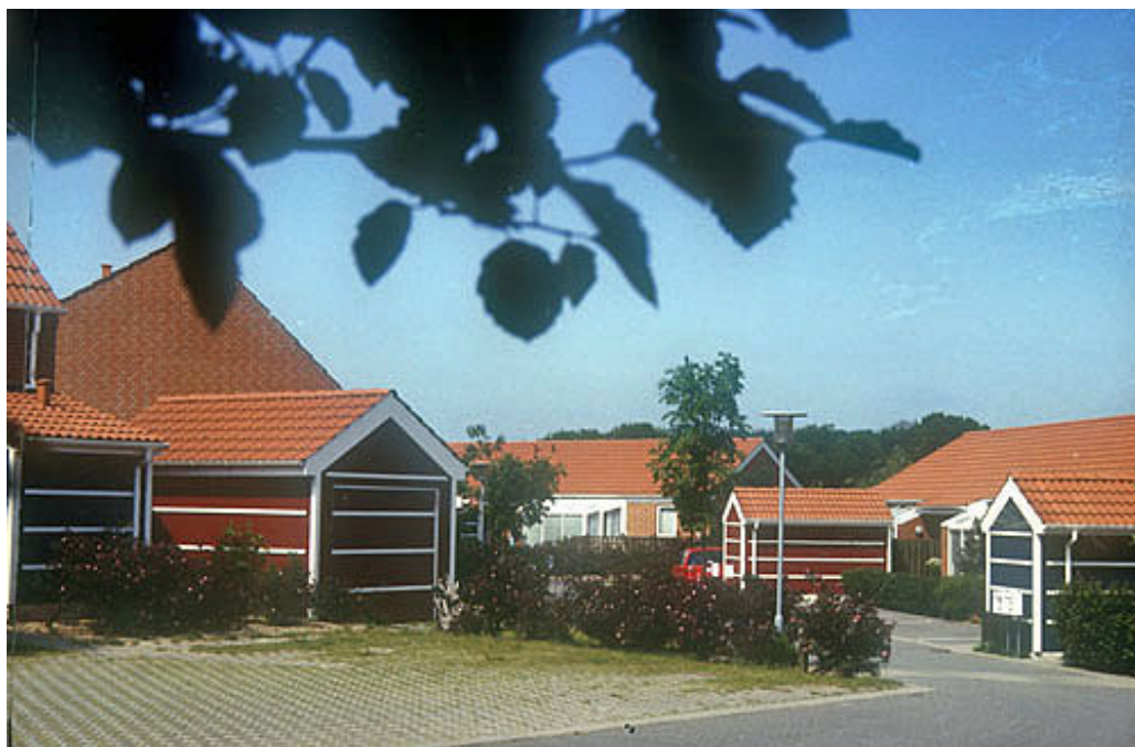
Hovedparten af byggeriet er en helstøbt tæt-lav bebyggelse omkring et gadeforløb, der følger landskabets terræn.
