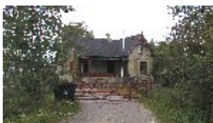
Naturbørnehaven er etableret i bevaringsværdige bygninger.
